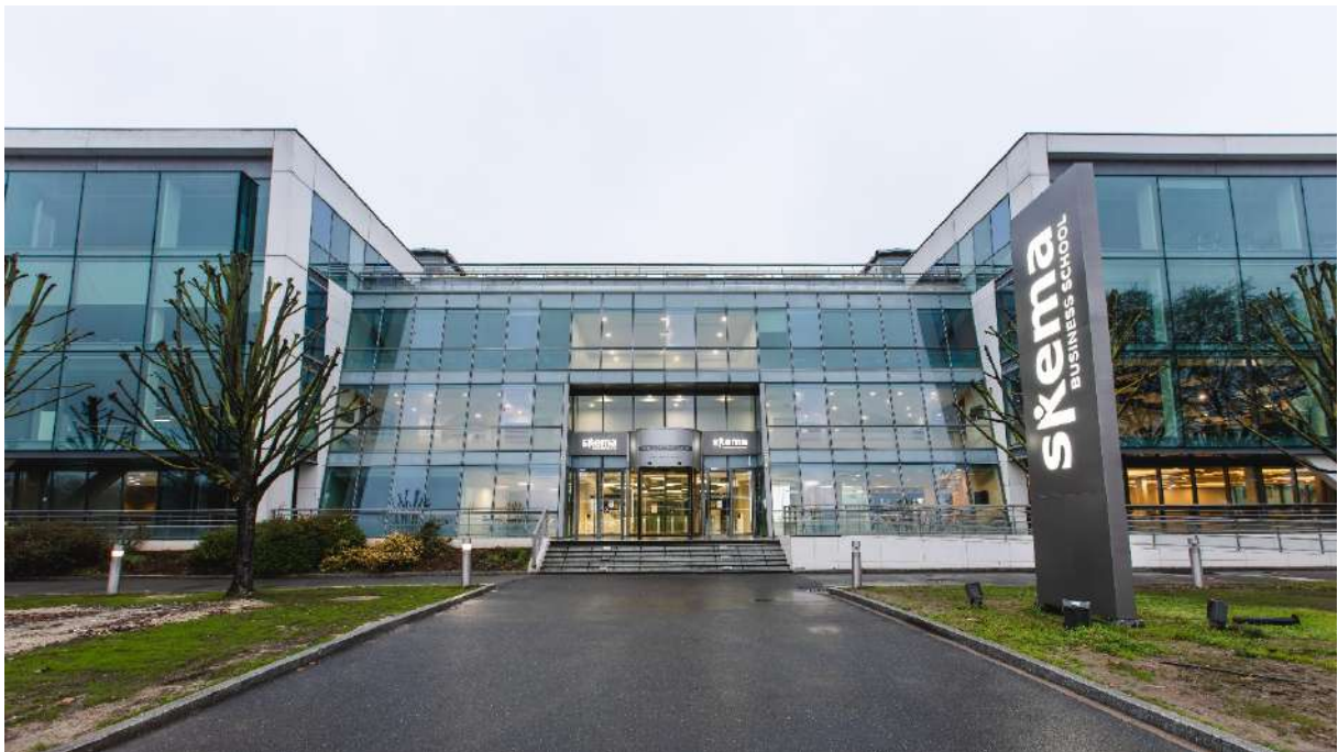
Hub de 30 000 m 2 , le nouveau Campus Grand Paris de SKEMA Business School a ouvert ses portes le 4 janvier 2020.
